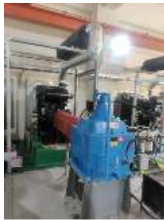
「金沙抽水站第二機組設施更新改善應急工程」完工照
