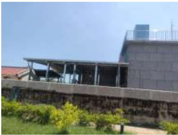
「金沙抽水站第二機組設施更新改善應急工程」完工照
