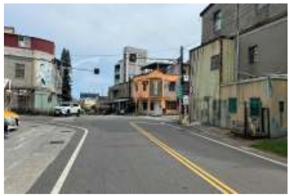
「金城鎮第七標污水下水道及用戶接管工程」完工照
