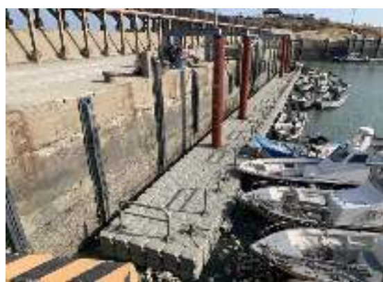
復國墩漁港浮動碼頭完工照
