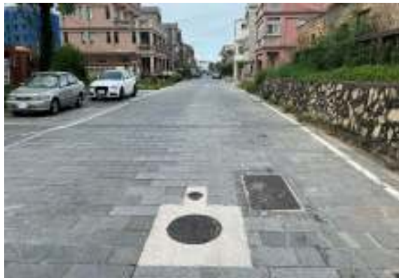
「金城鎮第七標污水下水道及用戶接管工程」完工照
